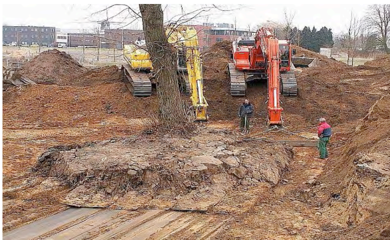
Figuur 7: voorbeeld van het verplaatsen van een boom. (bron Internet)
